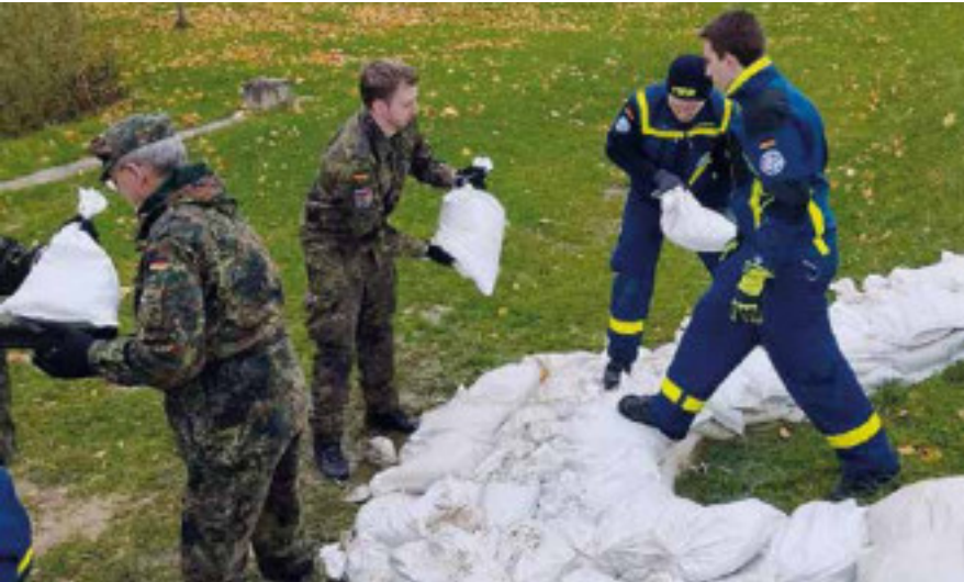
Reservisten und THW-Mitglieder stapeln Sandsäcke an einem Übungsdeich auf
